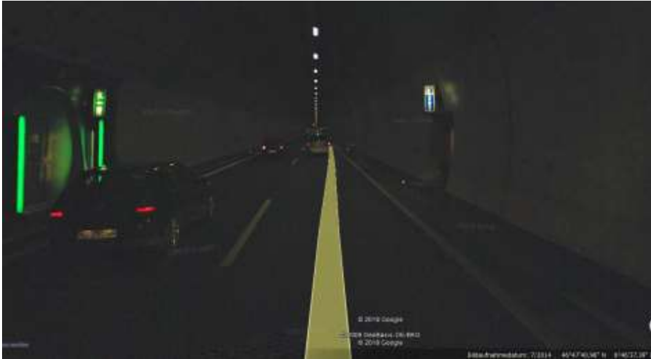
Links Rettungsstollen, rechts SOS-Nische
