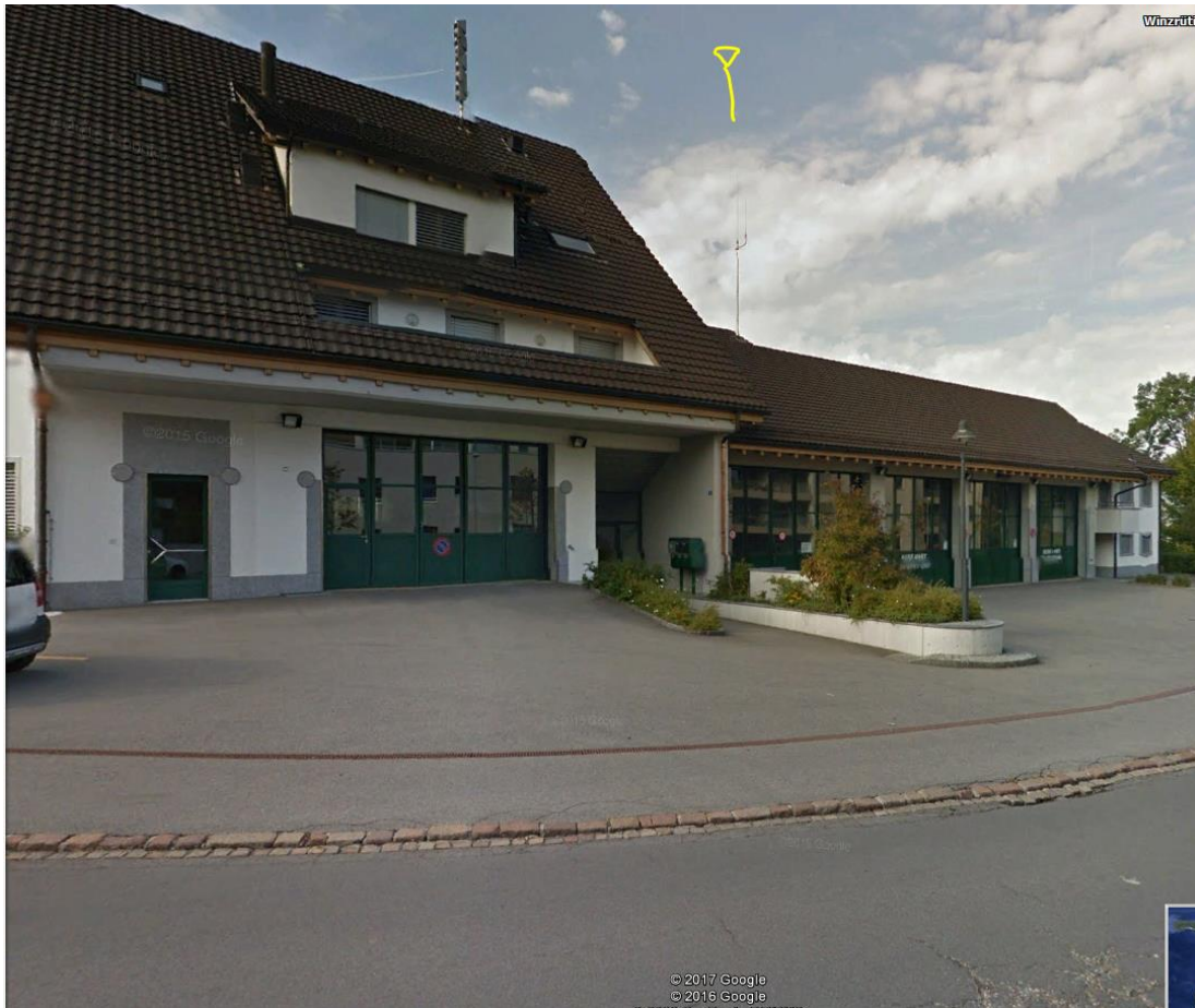
Feuerwehr mit Sendeanlage hier wäre der Traktor rechts vorbeigefahren.
