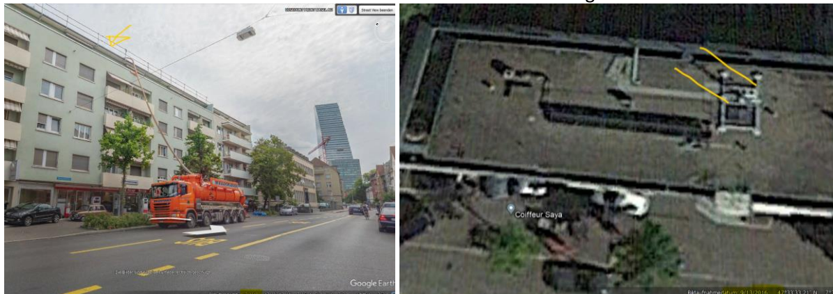
Das Dach des Standorts wird 2018 saniert. Der Standort dürfte durchgehend betrieben worden sein:
