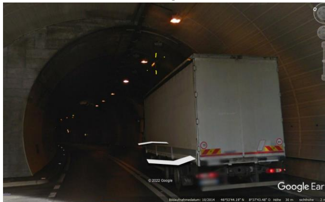
Tunnelausgang Süd ein Sender nach innen, ein weiterer ist nach aussen gerichtet
