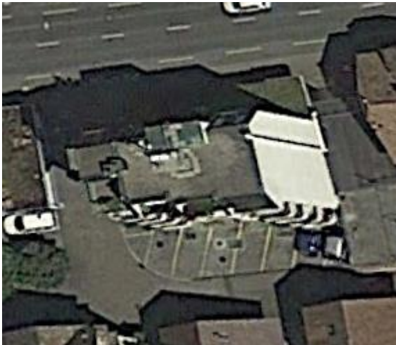
Gebäude mit Sender östlich.
