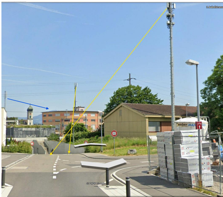
Der GSM-rail-Sender strahlt nur wenig in die Unterführung
