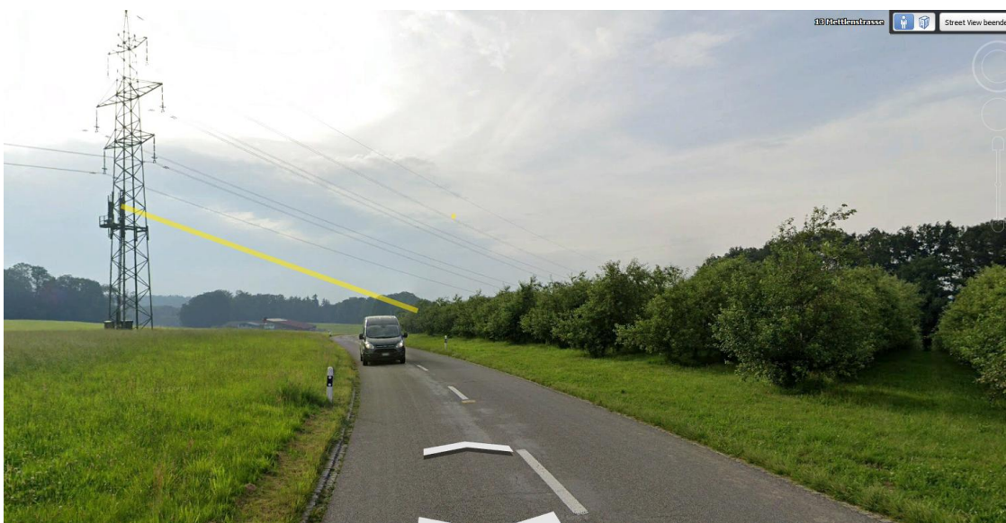
Swisscom 4G im Mast südöstlich, ca. 12 m Abstrahlhöhe
