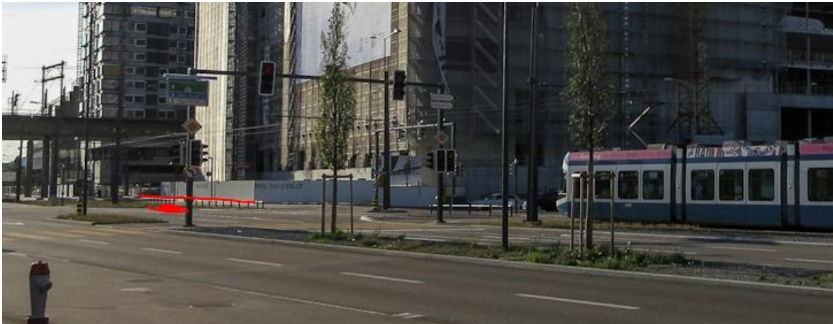
Die Fassade war ursprünglich aus Trapezblechen, reflektierte die Strahlung
