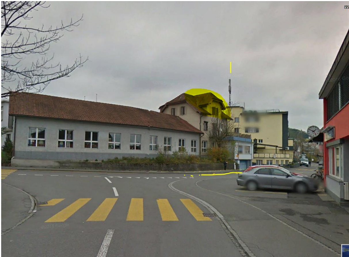
Gebäudedämmung des Dachgeschosses schwach, kein Metall.
