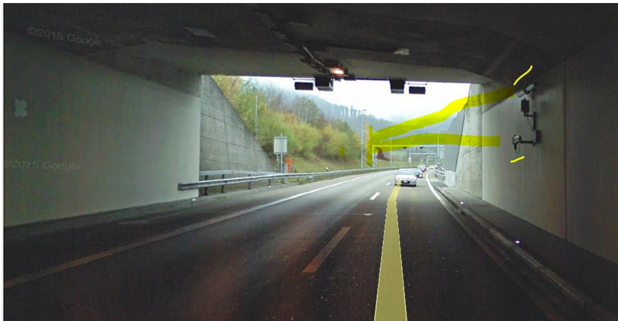
Links Nische sichtbar. Unten Eingang Tunnel, Sender sind links montiert, Kopfhöhe Fahrer.
