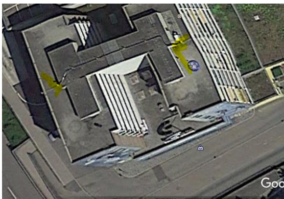
Sender an Aussenwänden des Technikgeschosses
