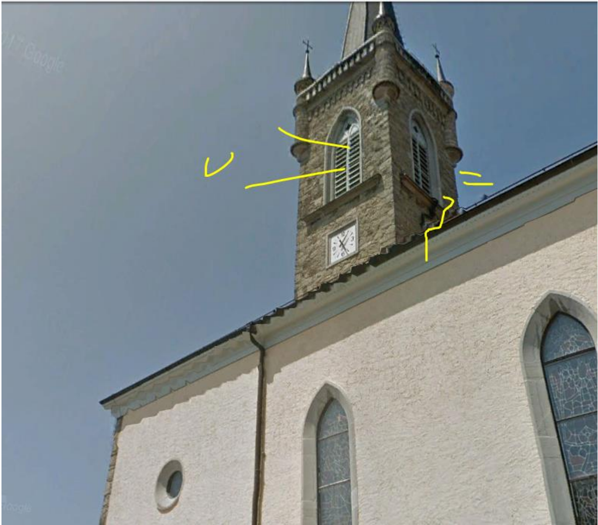
Kirchturmsender, er wird eine Senderichtung Süd zur Strasse hin aufweisen.
