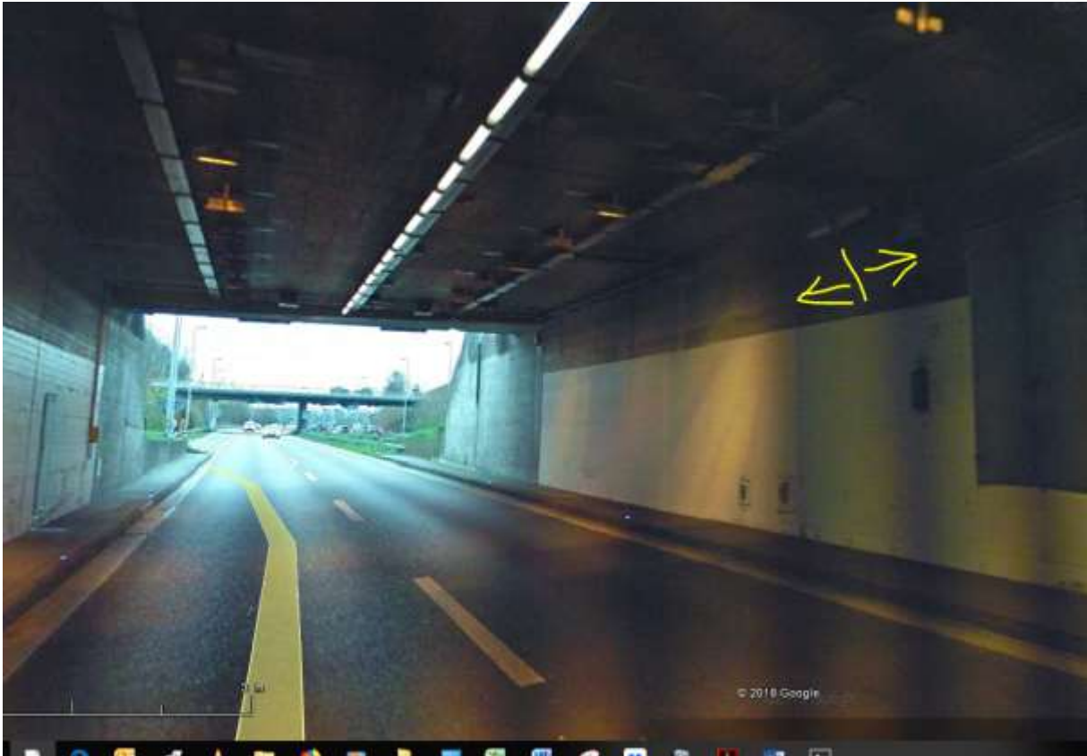
Nach dem Tunnel zwischen den Brücken 293
