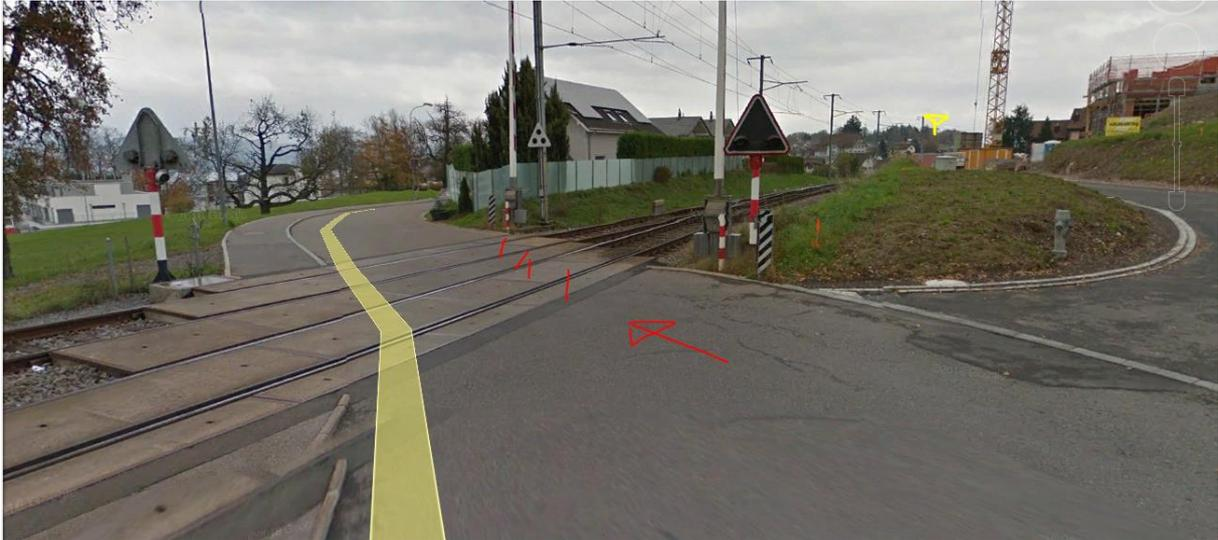
Bergabrichtung ist wahrscheinlicher. Sturz, ev zusätzlich versucht, unter senkenden Barrieren durchzufahren. SOB senkt Barriere knapp, nur etwa 10 Sekunden bis Zugdurchfahrt, wenn unten...
