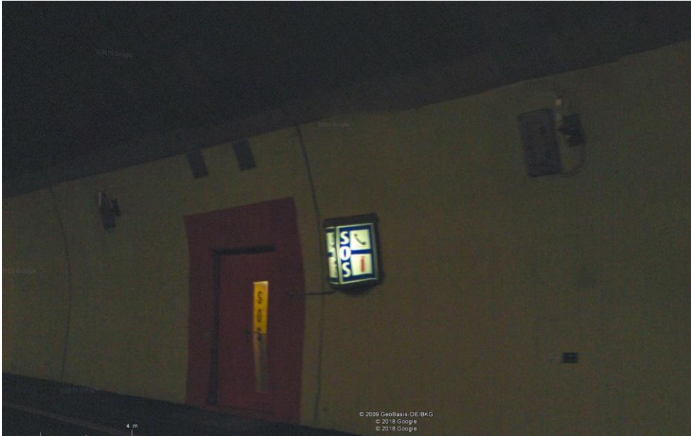
hier die beiden neben der SOS-Nische / Rettungstüre
