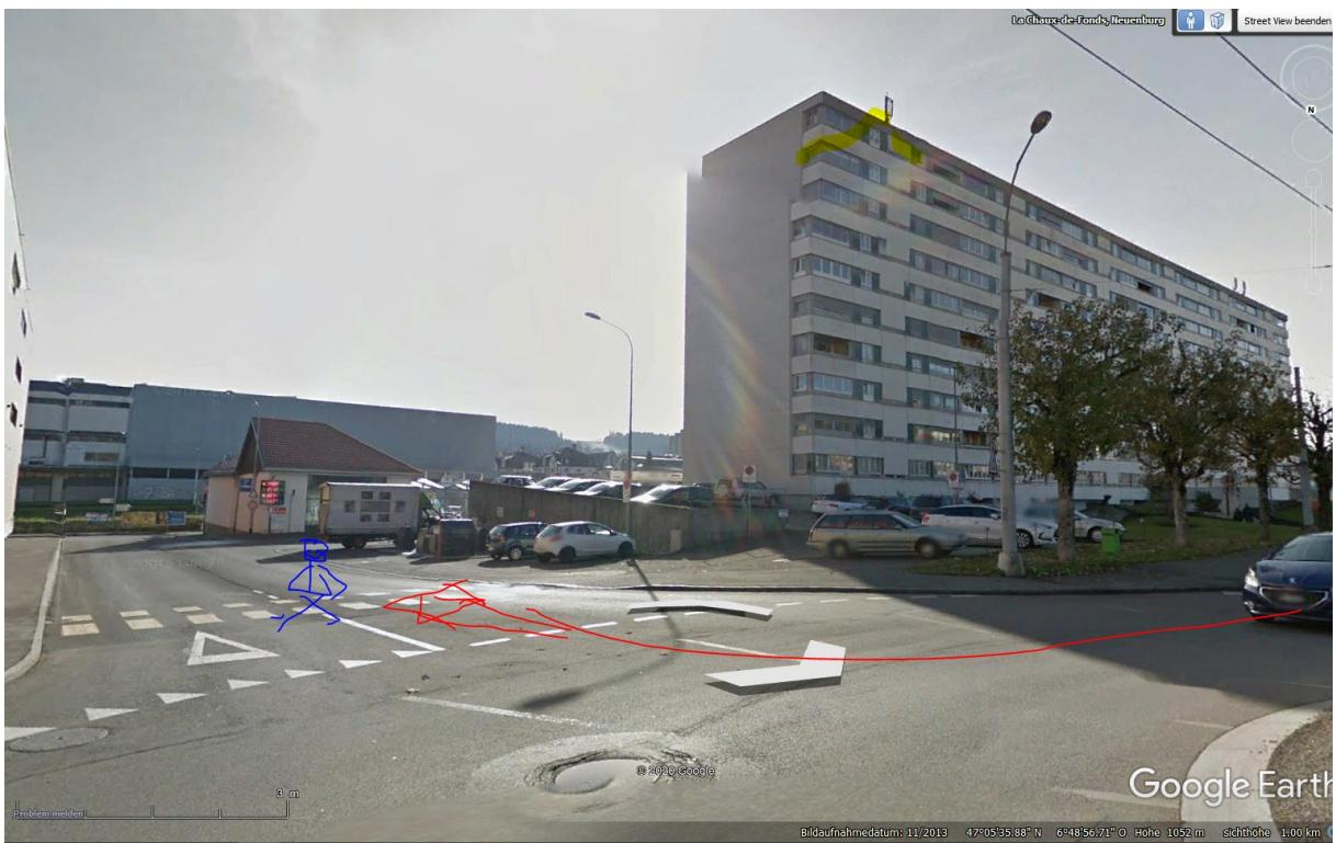
Die Fassade ist eine vorgehängte Konstruktion mit glasierten Keramikplatten, somit eine flächig reflektierende, Oberfläche
