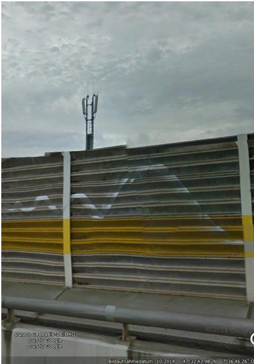
Sender mit deutlichem downtilt in Richtung Tunneleinfahrt
