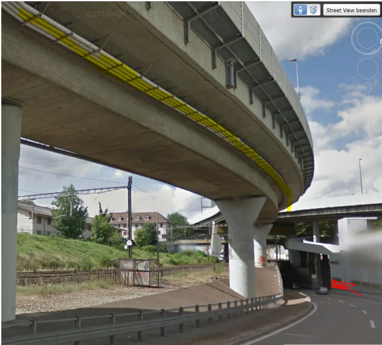
Doppelte Lage, unten 4 Kanalrohre.
