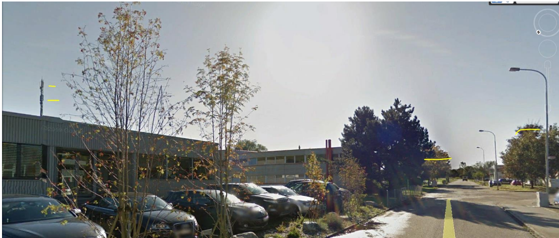
Ansicht Sender und Baumschäden an der Industriestrasse von Norden.
