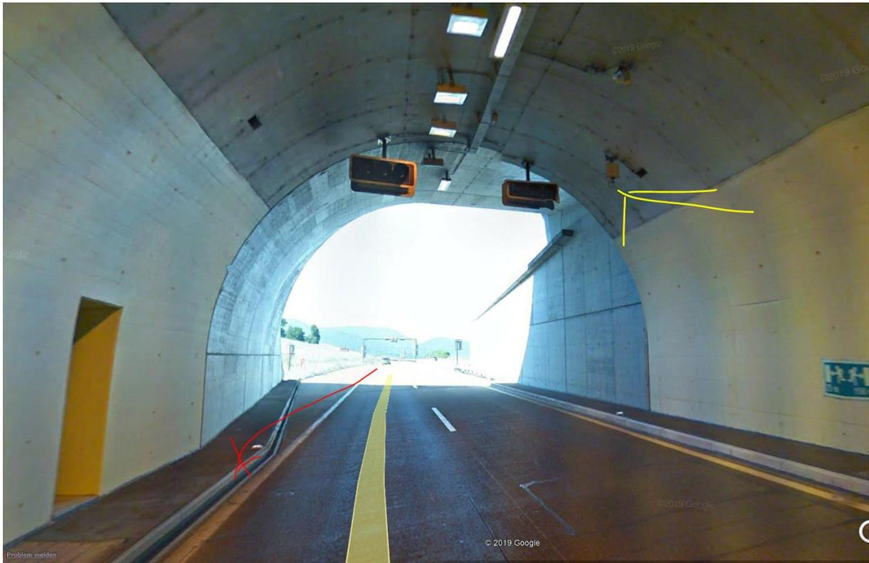
Der Sender strahlt mit seiner gezielten Leistung in die Röhre, die rückwärtigen Nebenkeulen reichen zur Versorgung der letzten 60m, bis der Sender oben / aussen übernimmt. Die nördliche Gegenröhre, falls benützt in diesem Unterhaltsfall, verfügt hier sogar über 3 frontale Sender.
