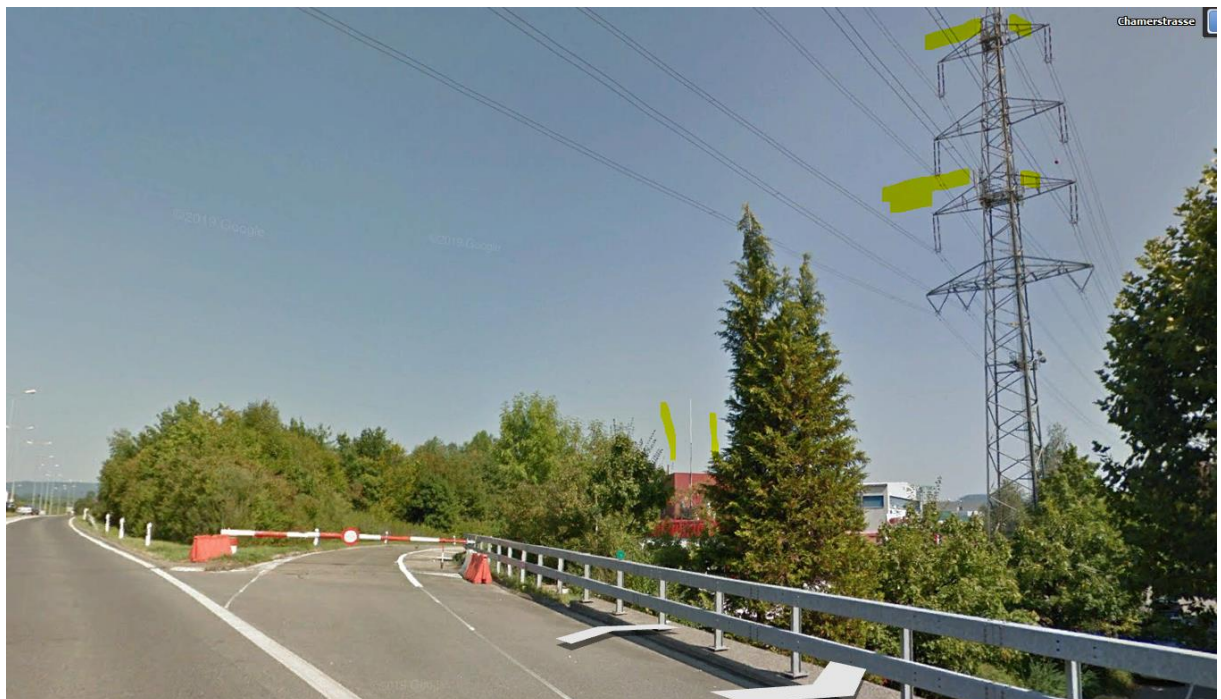
Doppelstandort im Hochspannungsmast. Wetter: trocken am 1.6.20
