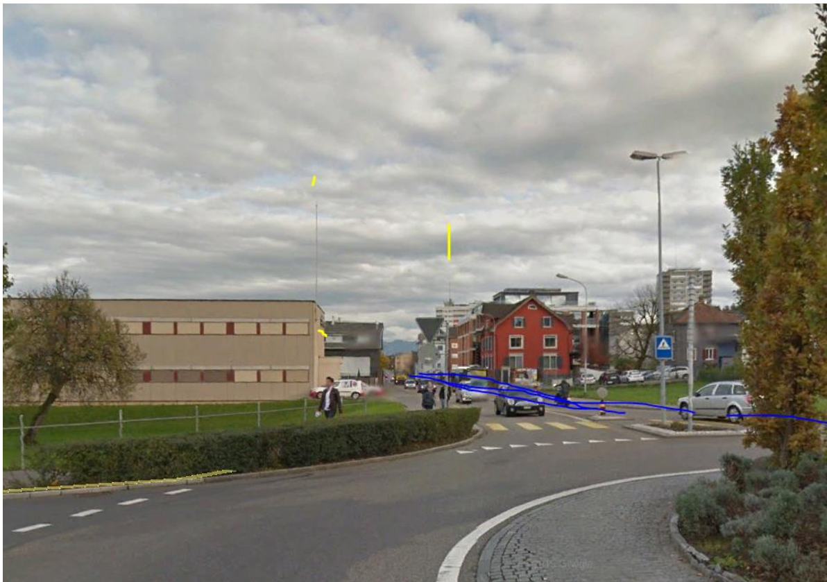
Anfahrstrecke.Swisscom-Gebäude mit Stab-Aussenantenne, unten von der Querstrasse her:
