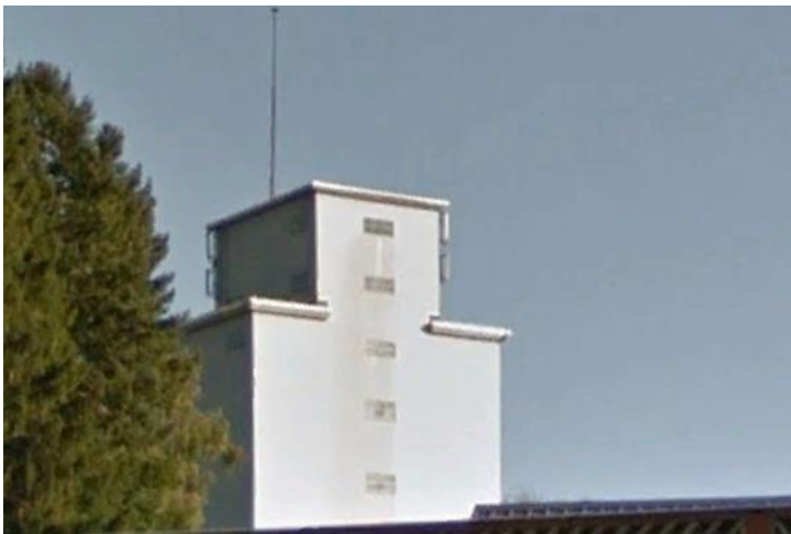
Ein Doppelstandort bei Silo /Kiesgrube von Autobahn aus gesehen
