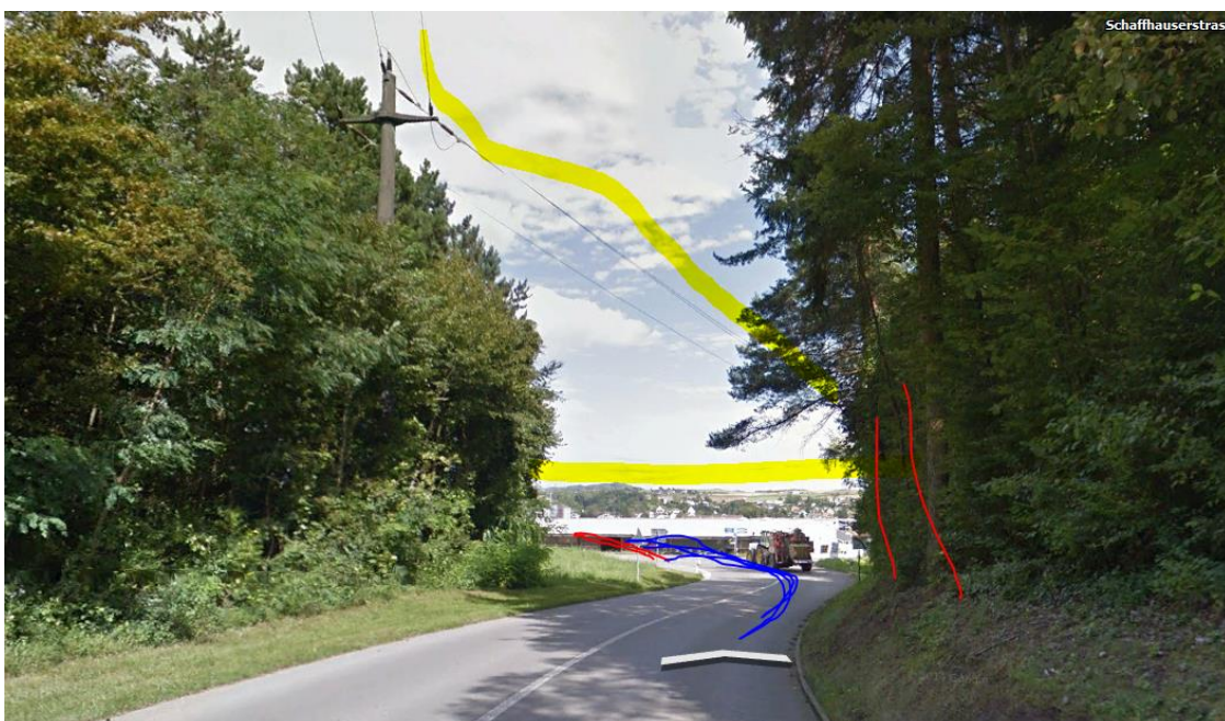
Querte eine Abfolge und dann eine Kreuzung von Hochspannungsleitungen Ebene 5 oder tiefer.
