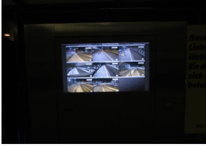
Messung bei den Monitoren der Überwachungskameras
