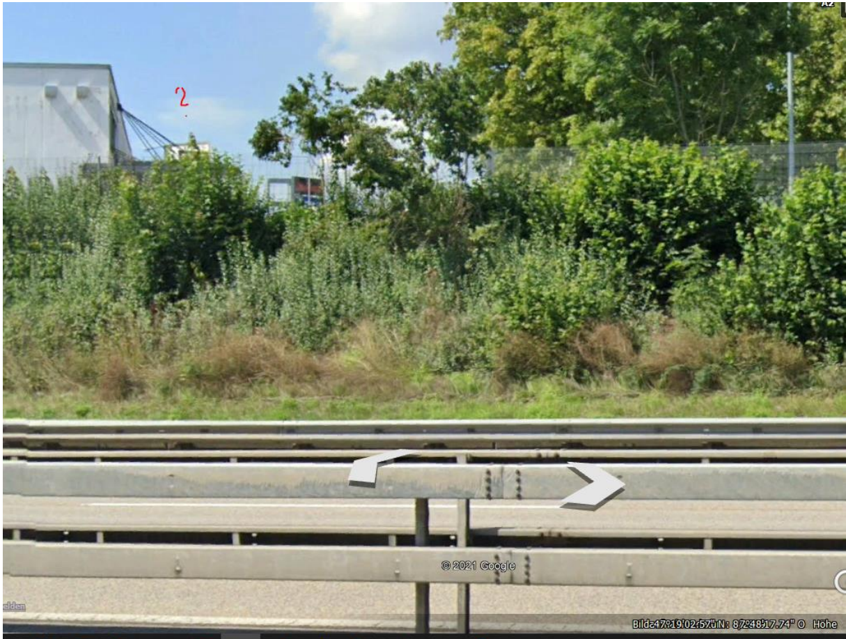
auf der Hausimollstrasse ist der nördliche Silo erkennbar
