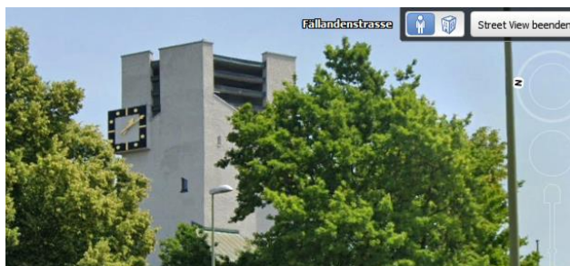
Seite Höglerstrasse (SW)
