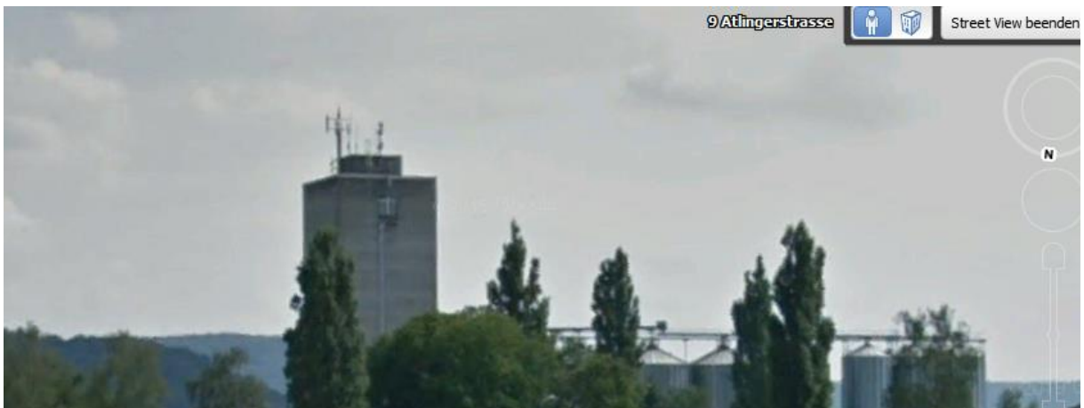
Der Silo ist Dreifach-Standort
