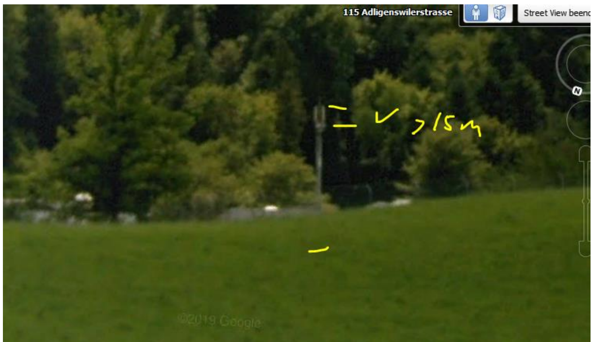
Der Sender vom Golfplatzgebäude ist hoch
