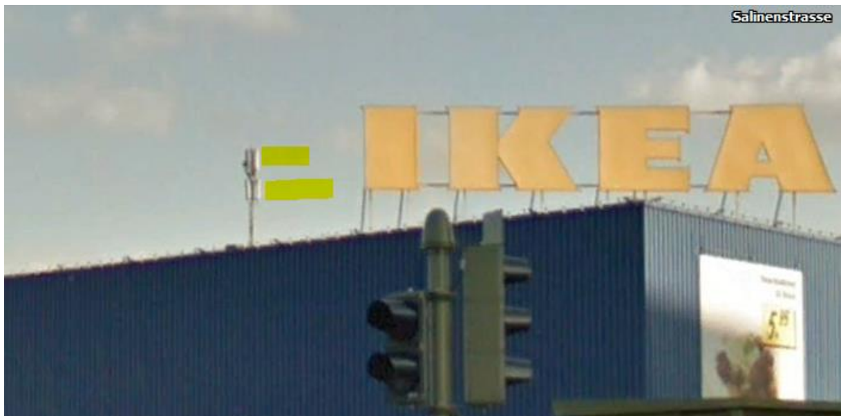
Der Sender südlich könnte reflektieren, aber vermutlich ist die Gebäudekante zu hoch:
