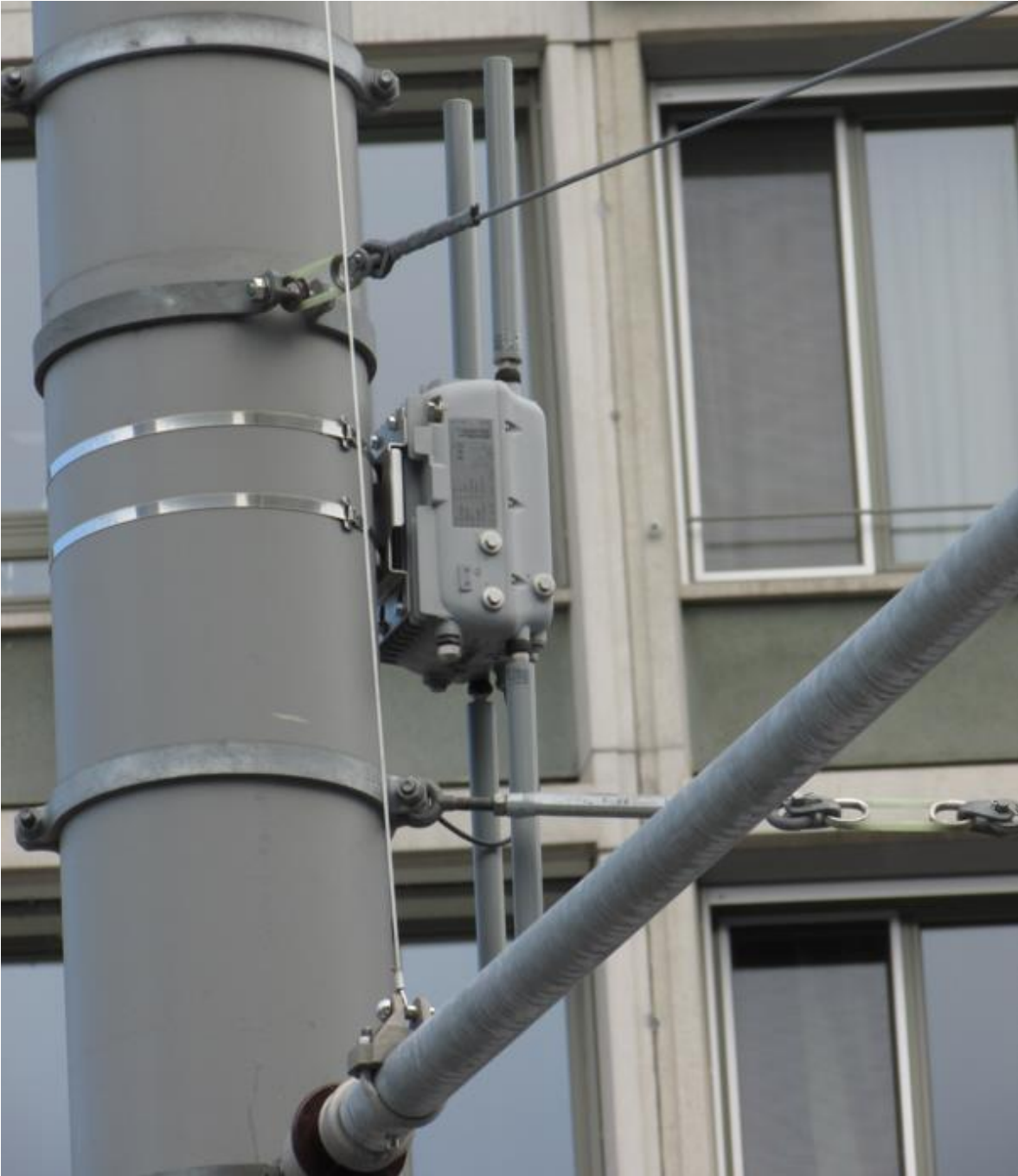
Dieser Standort ist auf dem Mast mitten im Platz, die Metallkonstruktion reflektiert hier zusätzlich
