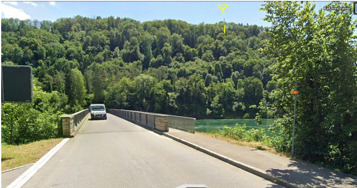
Ungefähre Lage der Baustelle am nördlichen Widerlager, Neubau zweite Brücke 2021, swisstopo:
