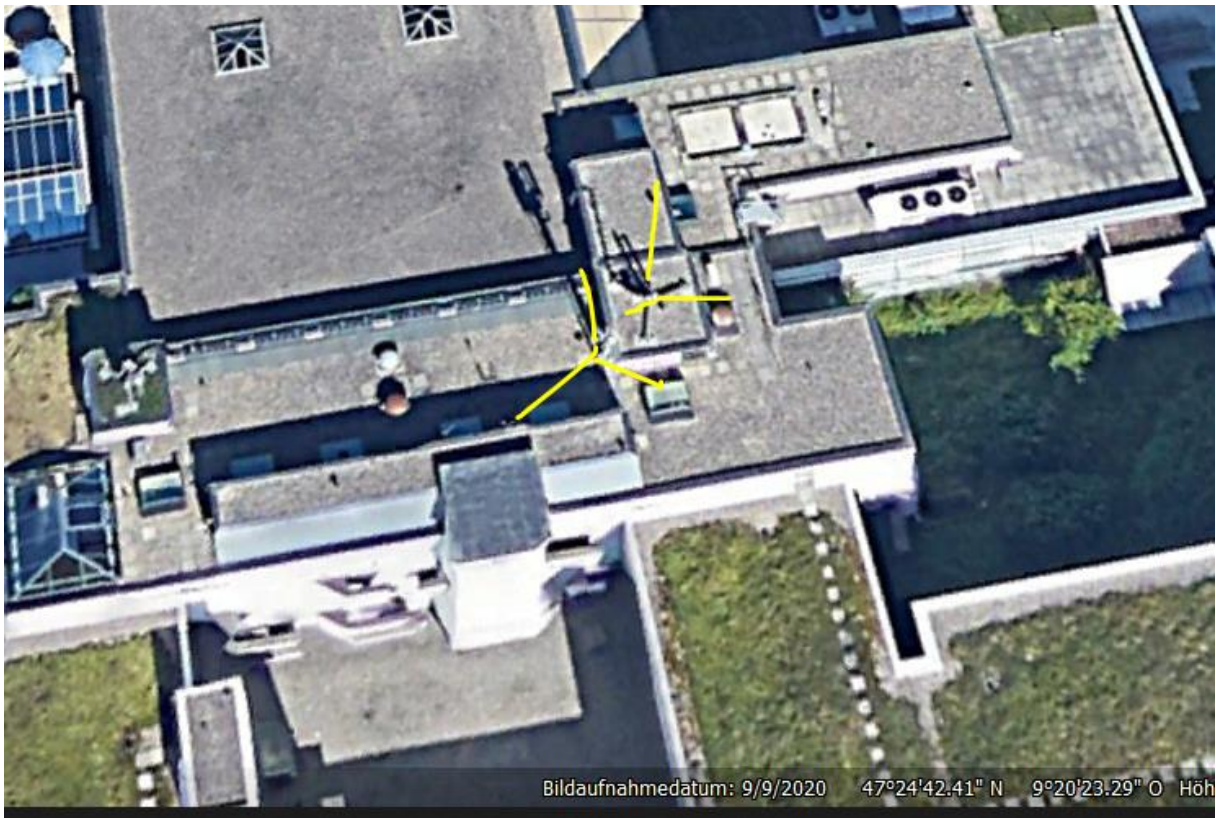
2 Anlagen auf dem Dach des „Tagblatt“-Gebäudes
