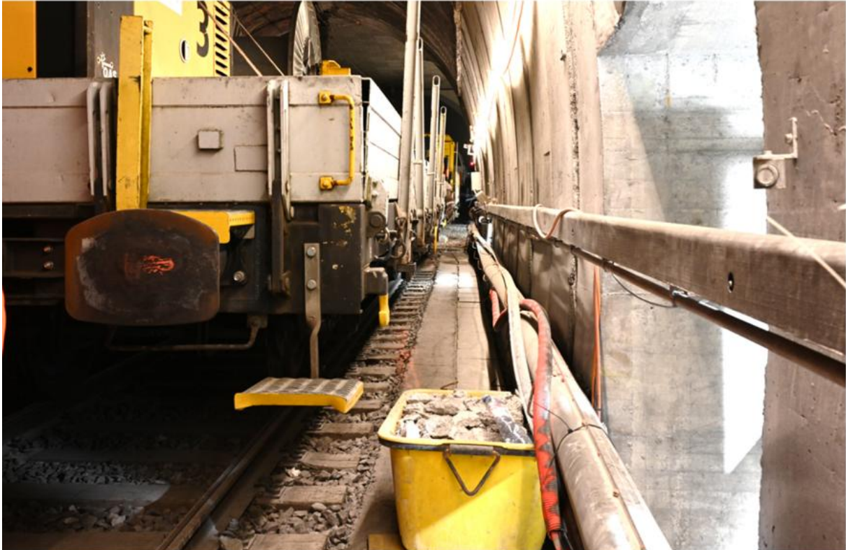
Abbildung 8: Bankett an der Tunnelwand als Gehweg, mit Hindernissen belegt und enge Platzverhältnisse.
