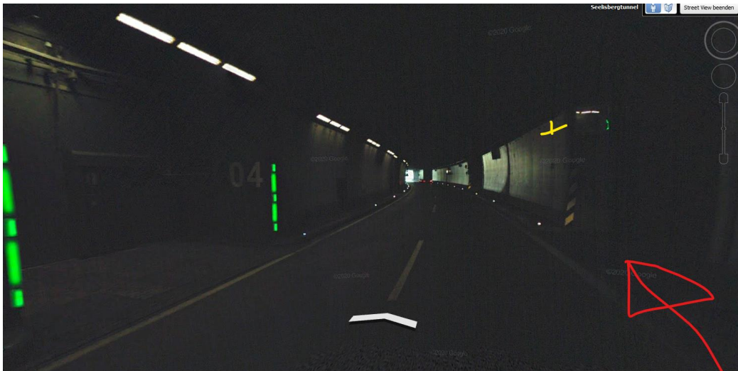
Dieser Film zeigt (leider schnell) die ganze vom Verunfallten bisher gefahrene Tunnelstrecke und die Nischenfolge Höhe Querschlag 4: https://www.youtube.com/watch?v=Gk6uuUicCIA
