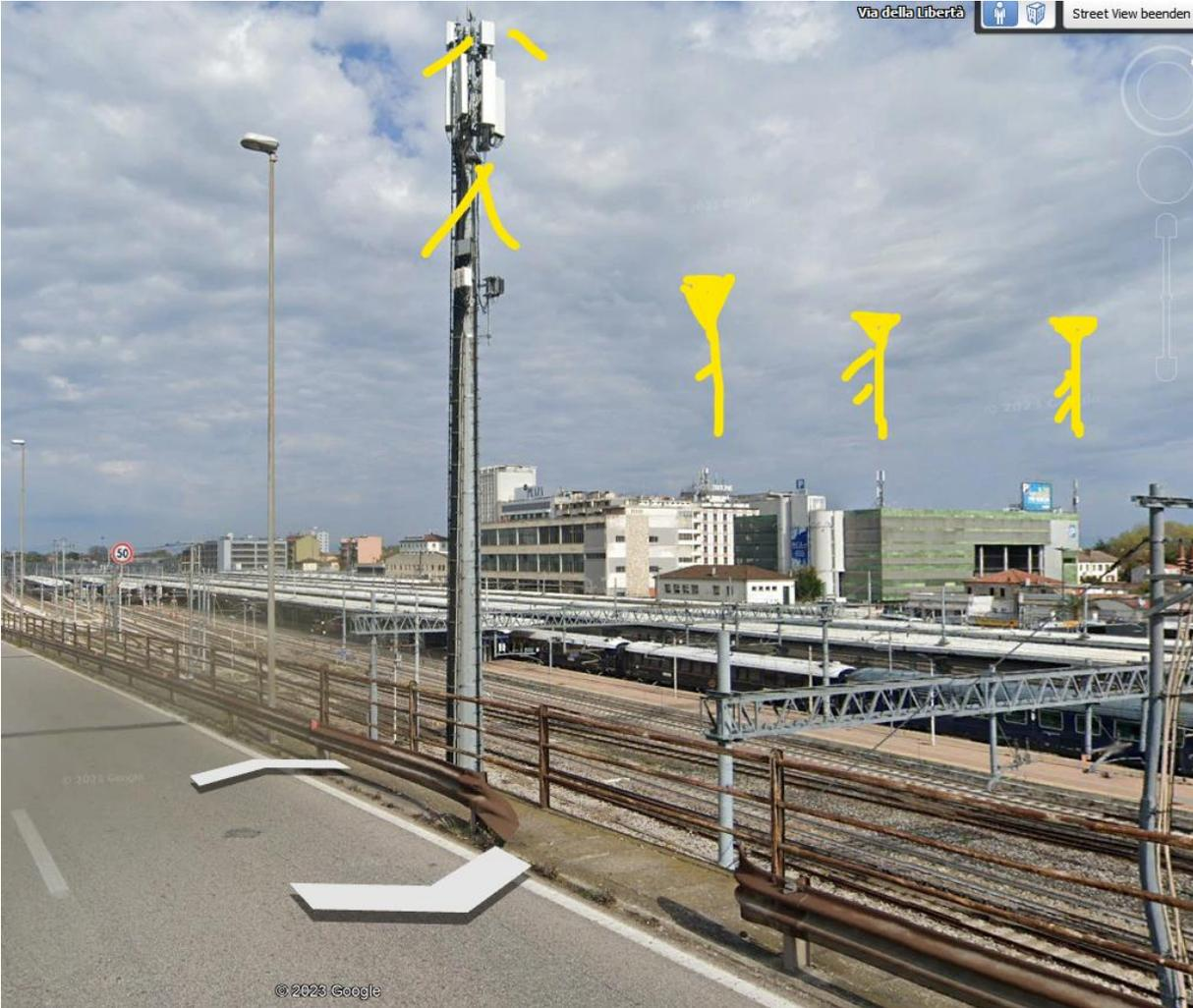
Der Sender hat hier eine Hauptstrahlrichtung zum Strassen- und Bahnverlauf. Die Elevation 0° führt zu einem Strahlungsmaximum auch der konventionellen Sender beim Auftauchen auf der Rampe:
